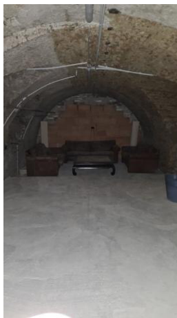
„Großer Raum“ – Richtung Abmauerung
