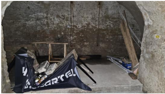
„Großer Raum“ – Hinterer Bereich
