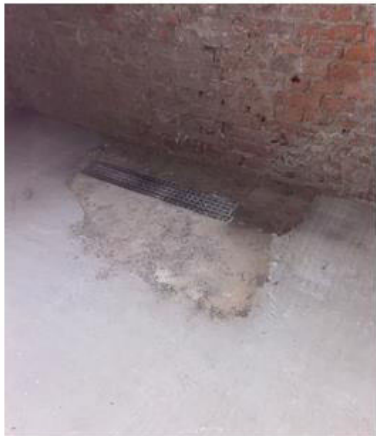
Lüftung von L2 zu L1 in Ordnung
