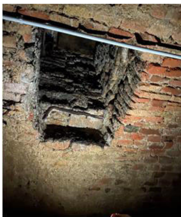
Öffnung im L2 zugemauert
